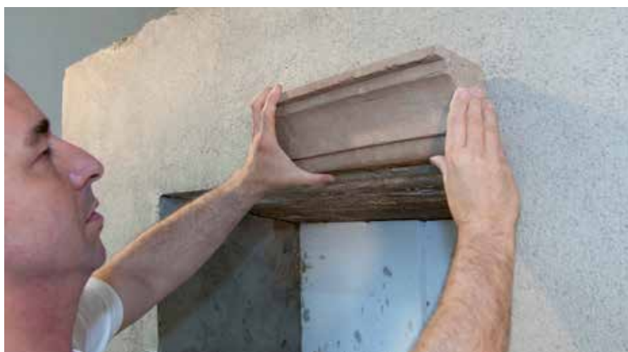
Montajul profilelor de decor
