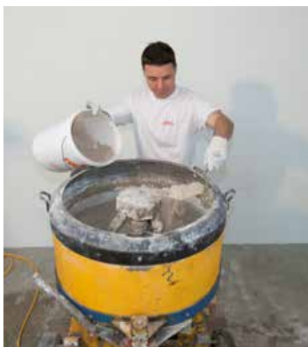
Turnarea nisipului și a varului hidraulic natural NHL Adăugarea apei
