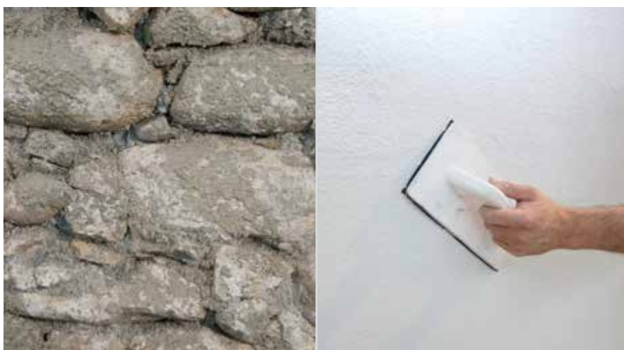
RÖFIX 671 Sanier-Vorspritzmörtel 60 % cu acoperire 60 % | Aplicarea și structurarea RÖFIX 650 alb
