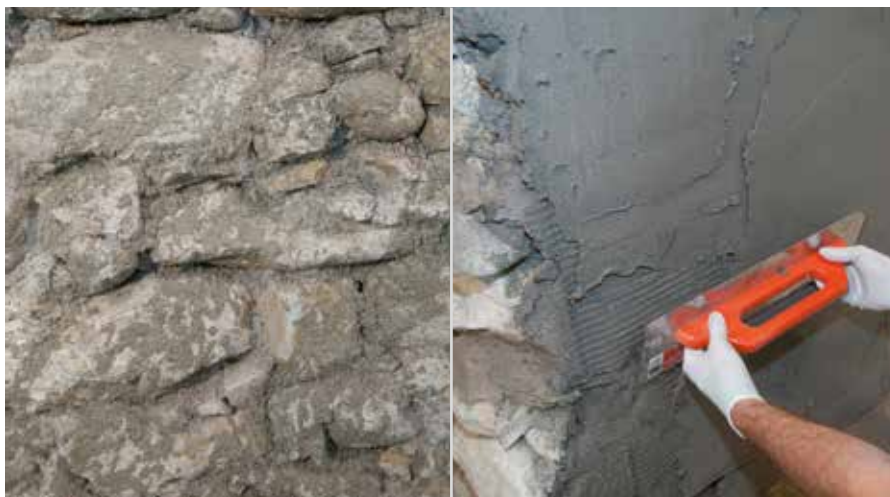
RÖFIX 671 Sanier-Vorspritzmörtel cu acoperire de 60 % Aplicarea HASIT 200 min. 20 mm
