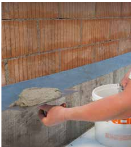
Bandă pentru fisuri RÖFIX ca prevenire a fisurilor
