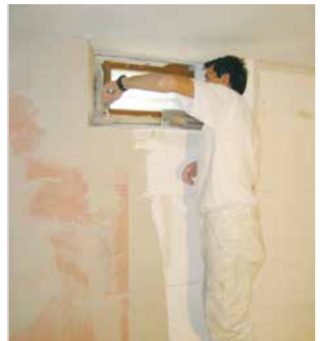
Montaj cu pană de ajustare RÖFIX Renopor® Anpasskeil
