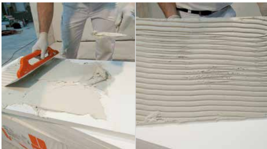
Lipire pe toată suprafața cu RÖFIX Renopor® Spezial-Klebespachtel (masă de șpaclu adezivă specială)
