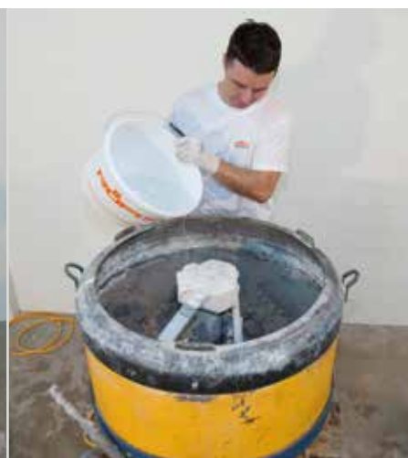
Turnarea nisipului și a varului hidraulic natural NHL Adăugarea apei
