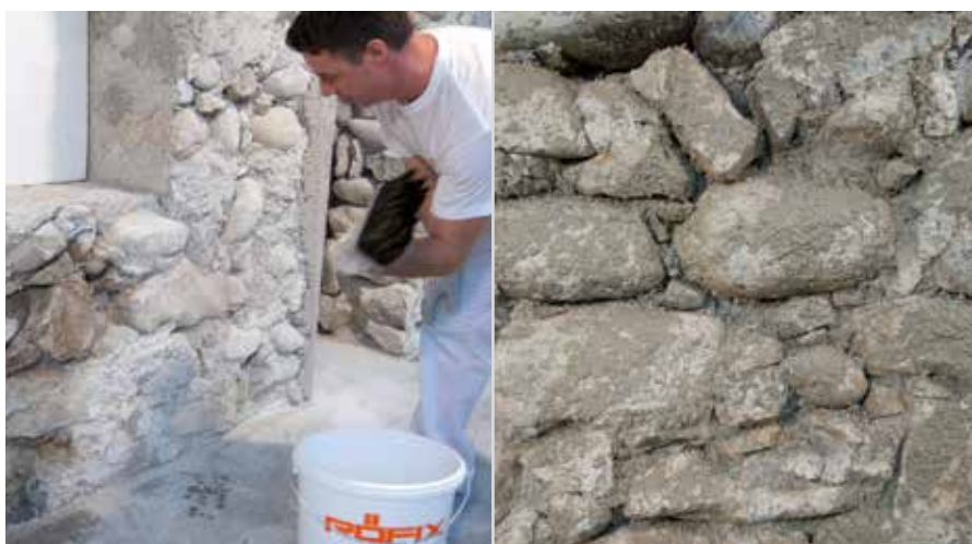
Acoperire prin aruncare cu RÖFIX Saniergrund cu ajutorul bidinelei
