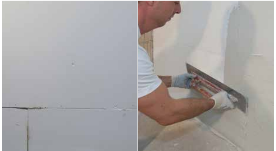
Rosturi îmbinate cap la cap | Armare cu masă de șpaclu adezivă specială RÖFIX Renopor® Spezial-Klebspachtel
