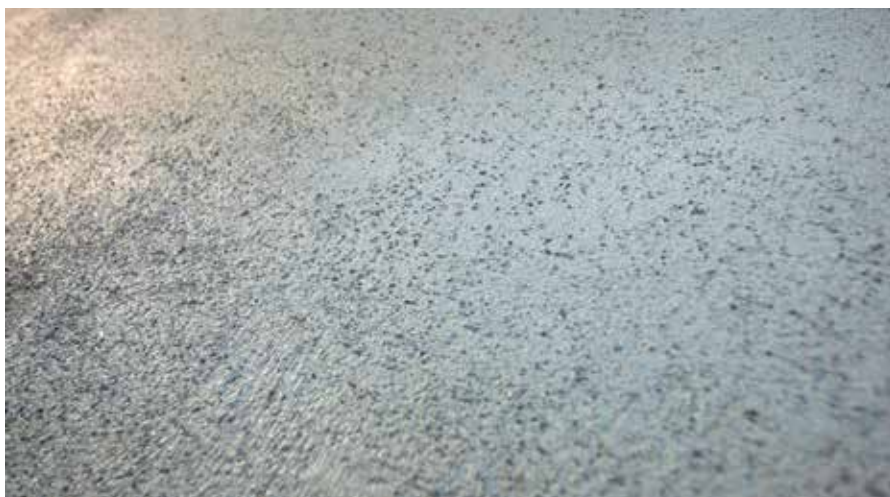
RÖFIX 397, structurarea celui de-al doilea strat
