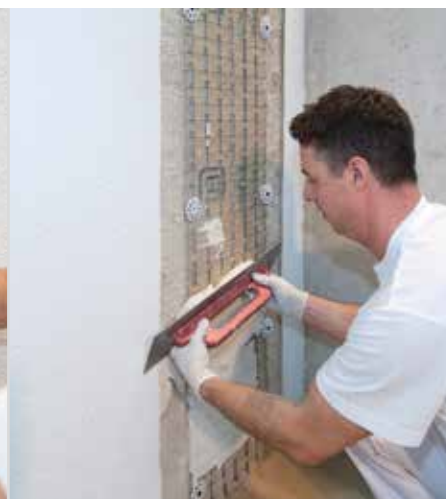
Punte de fisuri (RÖFIX Stucanet)
