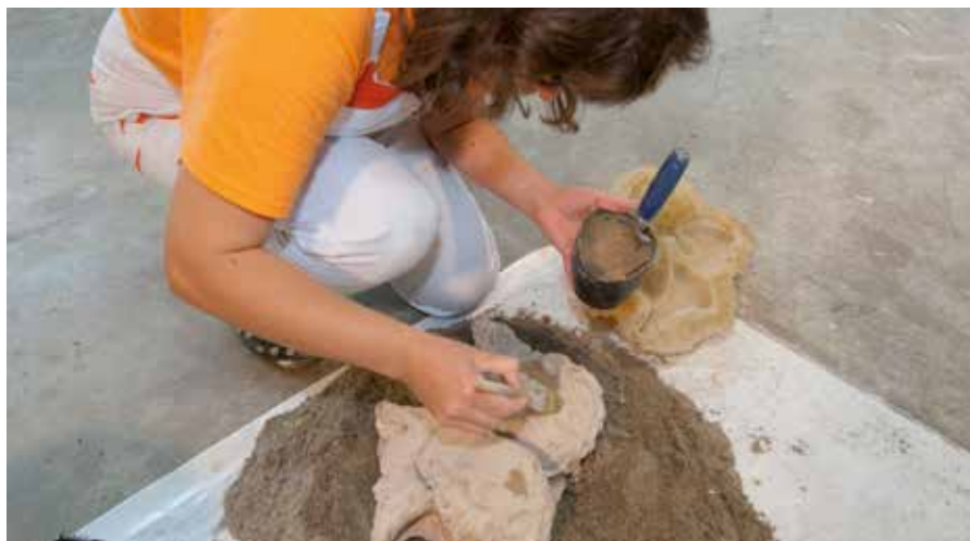
Finisarea mortarului de turnare cu RÖFIX Belit Feinschlämme
