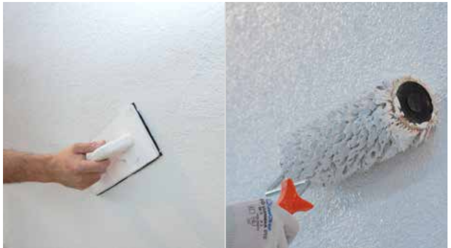
Structurare cu masă de șpaclu adezivă specială RÖFIX Renopor® | Acoperire cu vopsele cu difuzie deschisă la vaporii
