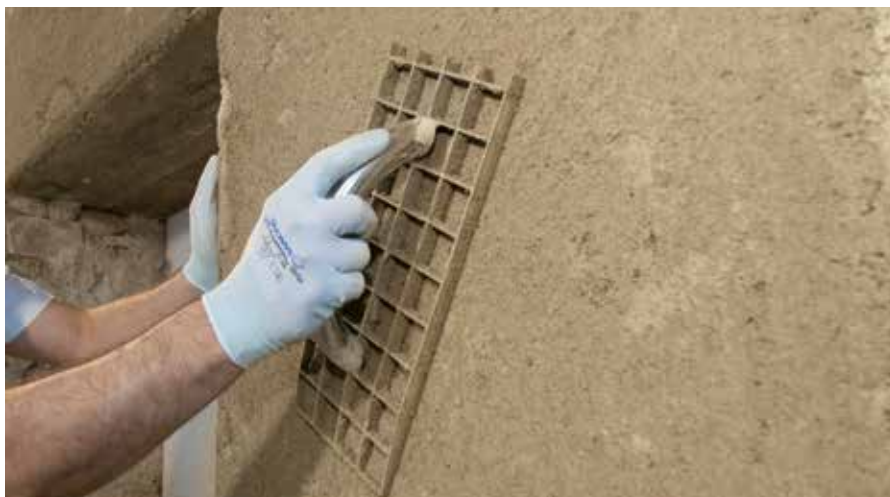
Zgărierea plană a RÖFIX CalceClima® Ambiente cu RÖFIX Schleifwunder
