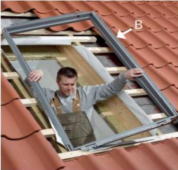
Figura 10. (c) Montajul ferestrelor de mansardă
