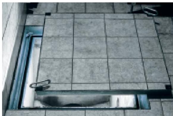
c. deschidere în placa de fundație sigilată etanș
